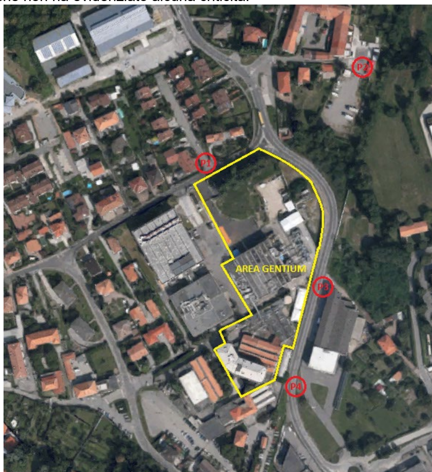
Figura 10: vista aerea del sito con punti di rilievo rumore - Fonte: google earth (in giallo l'area Gentium)
